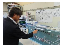
指令による現地補助制御盤取扱い訓練
