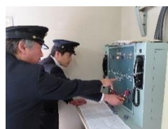
指令による現地補助制御盤取扱い訓練
