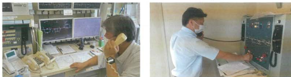
指令室と現地（富野駅）補助制御盤による信号取扱い訓練
