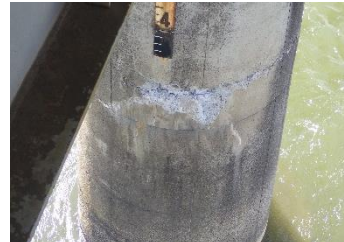
第1阿武隈川橋梁
